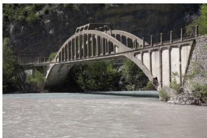
Pont de la Mescla Vue prise de l'aval
