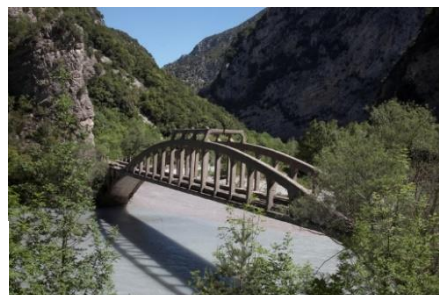
Pont de la Mescla Vue prise de l'amont en rive droite
